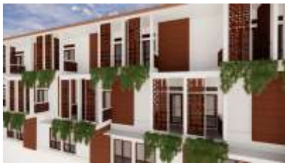
Gambar 5 Sunshading pada salah satu sisi bangunan sumber : dokumentasi pribadi
