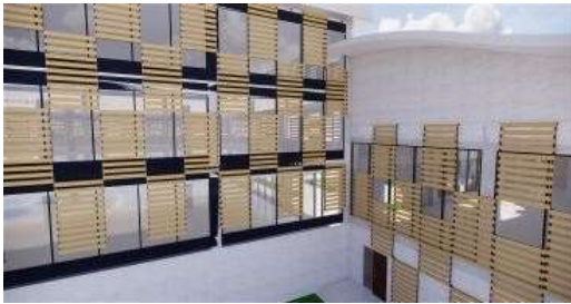
Gambar 9 Penerapan elemen fasad dengan material ACP pada eksterior bangunan
