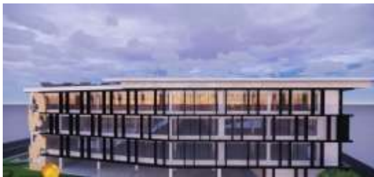
Gambar 10 Penggunaan rangka hollow aluminium pada fasad
