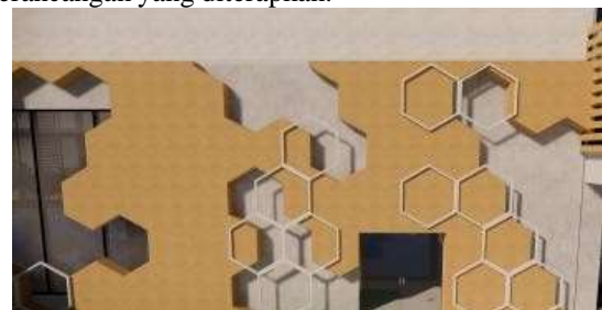
Gambar 8 Penerapan elemen fasad dengan material aluminium composite panel (ACP) pada eksterior (tampilan luar) bangunan
